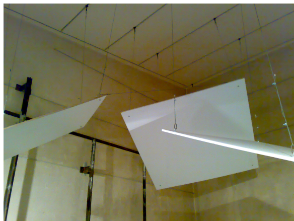
Figuur 5: Een Reverb Room, met hangende platen die voor extra galm moeten zorgen. (Fotograaf: Bick (2008)).
